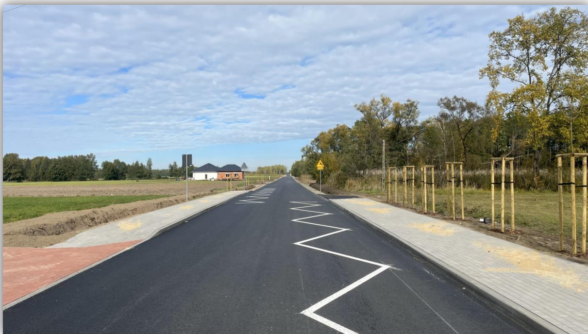
Przebudowa drogi powiatowej nr 2246W Stara Wieś – Wólka Dłużewska – Parysów od km 0+345 do km 2+190
