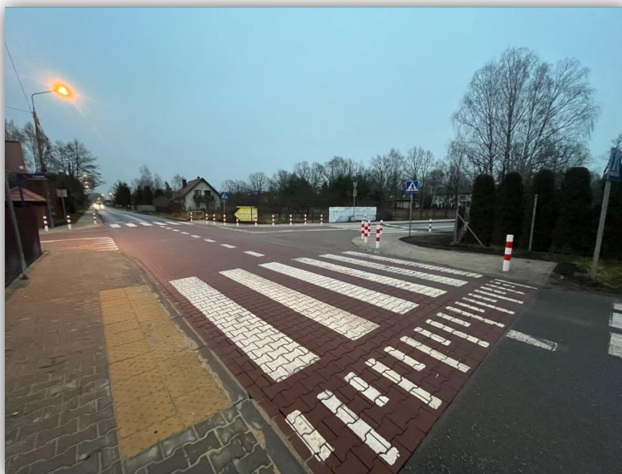
Przebudowa skrzyżowania ul. Stołecznej, Dąbrowskiego, Spacerowej i Chojniak w gminie Halinów
