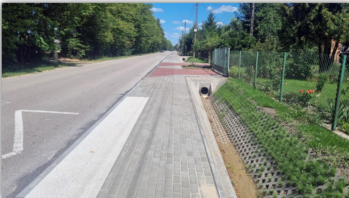
Przebudowa drogi powiatowej nr 2242W Stara Wieś – Siodło – Kuflew polegająca na budowie chodnika od km 0+060 do km 1+055
