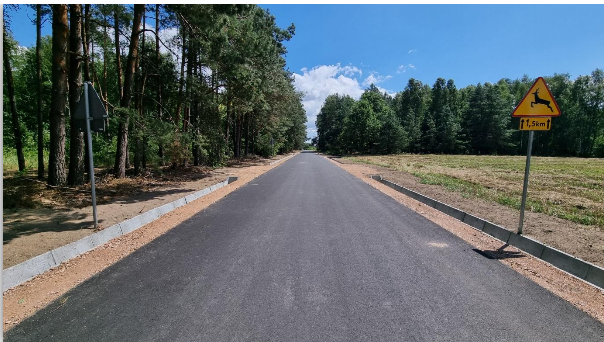
Przebudowa drogi powiatowej nr 2241W Posiadały – Kiczki – Wężyczyn – Jeruzal od km 5+385 do km 5+660
