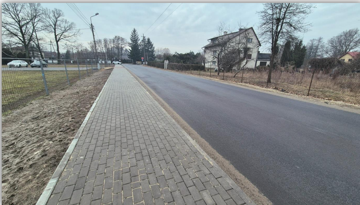
Rozbudowa drogi powiatowej Halinów – Krzewina – Desno od km 0+009 do km 0+102 (ul. 3 Maja)
