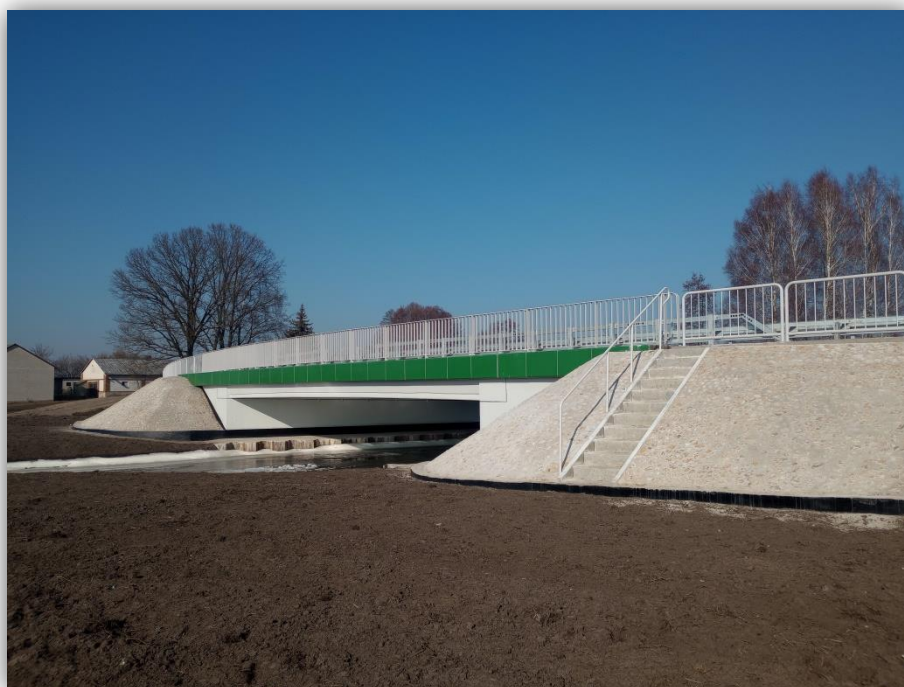
Rozbudowa drogi powiatowej nr 2236W Dębe Małe – Transbór – Starogród polegająca na rozbiórce istniejącego mostu oraz budowie nowego obiektu mostowego
