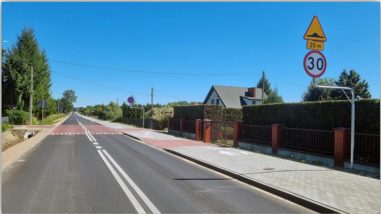
Rozbudowa drogi powiatowej nr 2230W Mińsk Mazowiecki – Cegłów – Mrozy od km 11+977 do km 14+035
