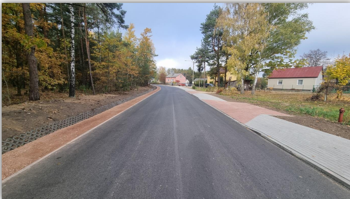
Przebudowa drogi powiatowej nr 2214W Stanisławów – Młęcin – Kamionka od km 1+180 do km 2+013
